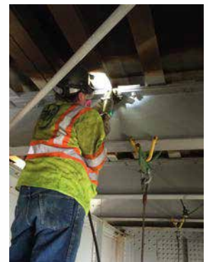
• Anwendungsbeispiel: Verbindungen Bodenträger - George Washington Brücke
